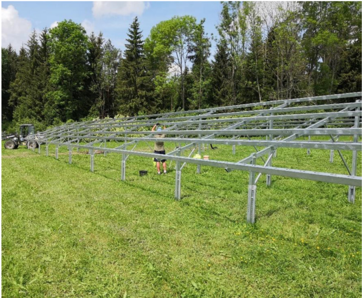
Abbildung 5: Beispielfoto für die Montage einer Freiflächenanlage mit Aufständering
